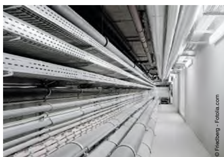
Befestigung von Kabelschächten
